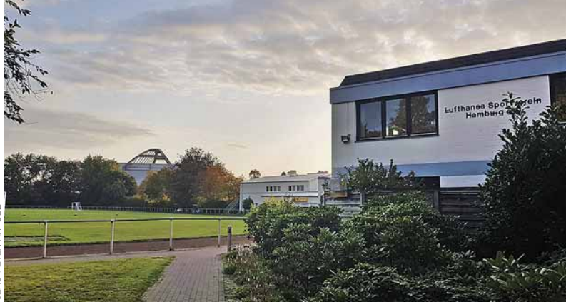
Die LSV-Sportanlage wird in diesem Jahr umfassend saniert
